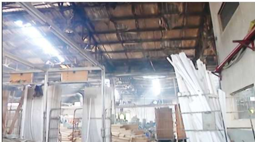
Sử dụng tấm cách nhiệt - tác nhân khiến một nhà xưởng tại quận Thủ Đức bị thiếu rui
